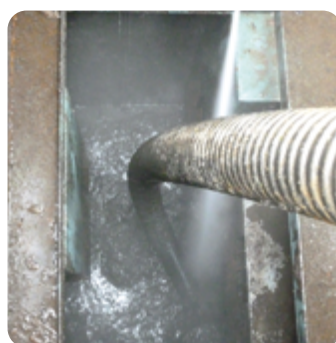
Nettoyage des parois par lance haute-pression
